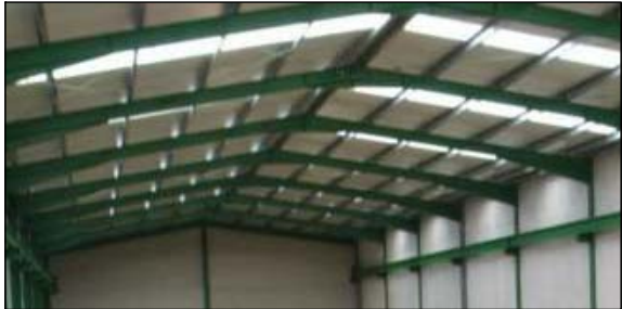
DETALLES FOTOGRAFICOS DE CUBIERTA
